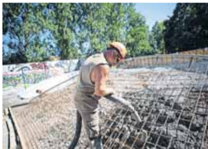
Červenec a srpen – budování nových prvků, betonuje odborná firma.
