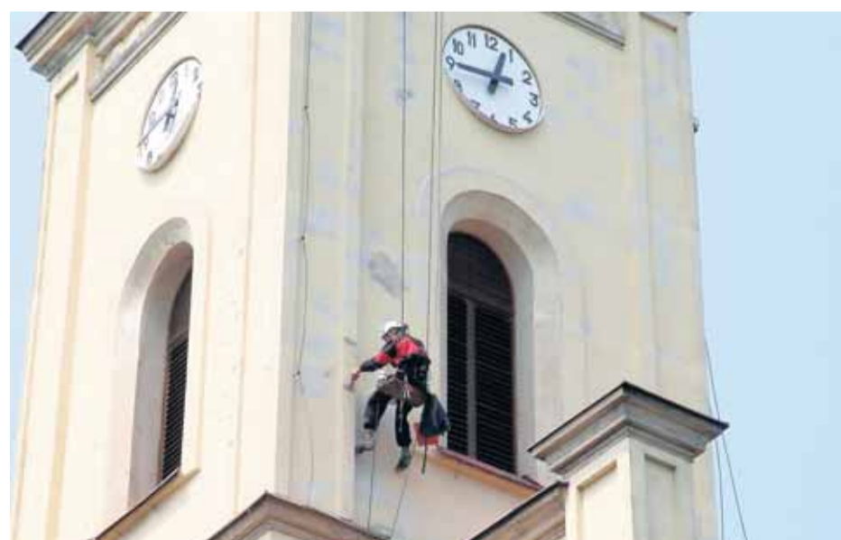
Kostel prodělal opravu fasády i oken.
