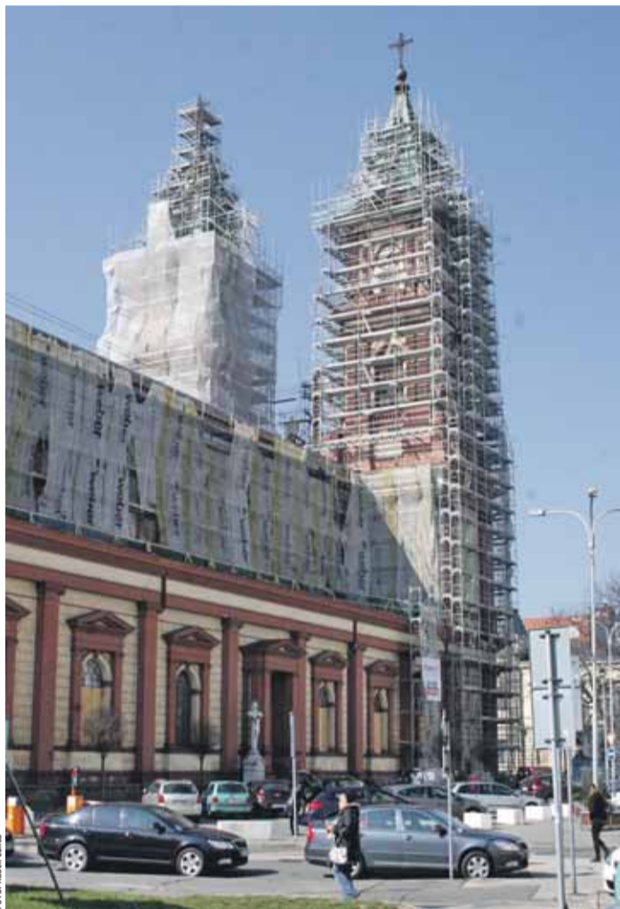
Katedrála, stojící na náměstí Msgre. Šrámka, je obestavěna lešením a zakryta.
