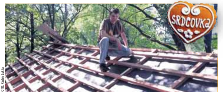
Petr Gebolisz během letní rekonstrukce střechy klubovny.
